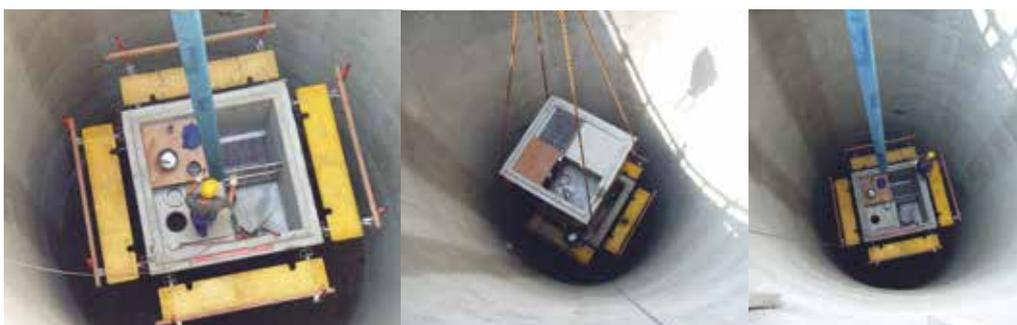
Bilder links: Absturzbauwerk zur Einleitung von Oberflächenwasser in 18 m tiefer liegenden Kanal. Betonfertigteile/Zellenbauweise. Montagezeit: 1 Tag (Spezial-Betonkleber).
