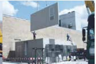
14:00 Uhr: Positionierung der Wand-, Decken- und Dachelemente per Kran
