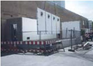
13:30 Uhr: Vorber. Aufbau für zwei Etagen mit ebenerdigen Trafowannen
