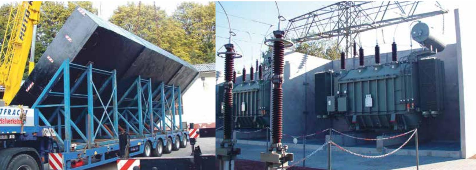
Beispiel für Trafofundament mit Brandschutzwand (zwischen den Trafos) sowie zwei Schallschutzwänden (je 11 x 6 m) zum Wohngebiet.
