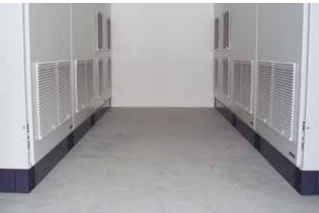
Links: Doppelbodenplatten aus Holzwerkstoff mit (Beispiel) Oberseite grauer PVC-Belag, unterseitig Alu-Feinblech.
