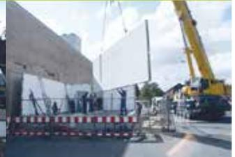
11:30 Uhr: Anlieferung der im Werk vorgefertigten Bauteile, Außenwand
