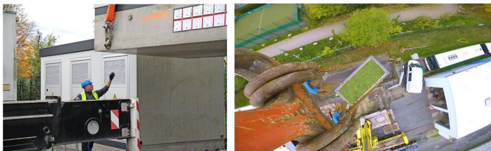
Präzision ist alles beim Aufbau der Trafostationen für das Busdepot der Stadtwerke Dortmund: Spektakuläre Anlieferung der Trafostationen mittels 300-Tonnen-Spezialkran.
